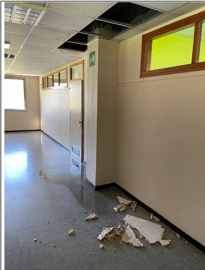
Infiltrazione d'acqua
