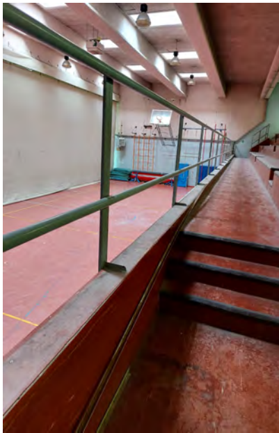
Spalti delle palestre: parapetto non a norma
